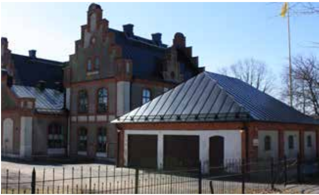
Ovan: F d stallbyggnaden som idag fungerar som förråd. Fasad mot öster.
