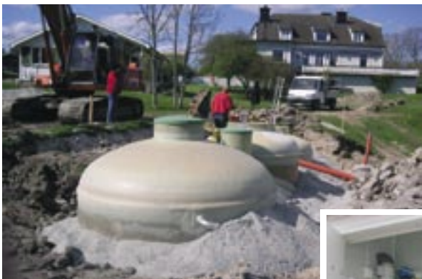
Bilderna visar installation av ett BAGA reningsverk med fristående serviceskåp vid Eriksbergs Naturreservat, Karlshamns kommun. Anläggningen har en kapacitet motsvarande 30 hushåll. Installationen utförd av Bengt's Gräv-tjänst i Tomelilla.
