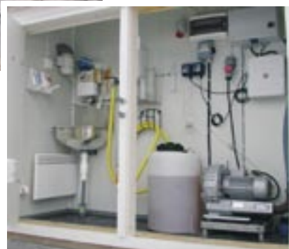
Bilderna visar installation av ett BAGA reningsverk med fristående serviceskåp vid Eriksbergs Naturreservat, Karlshamns kommun. Anläggningen har en kapacitet motsvarande 30 hushåll. Installationen utförd av Bengt's Gräv-tjänst i Tomelilla.
