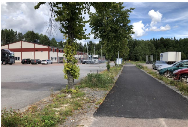
Ovan: Gång- och cykelbana längs Kronvägen sett mot väg 175.
