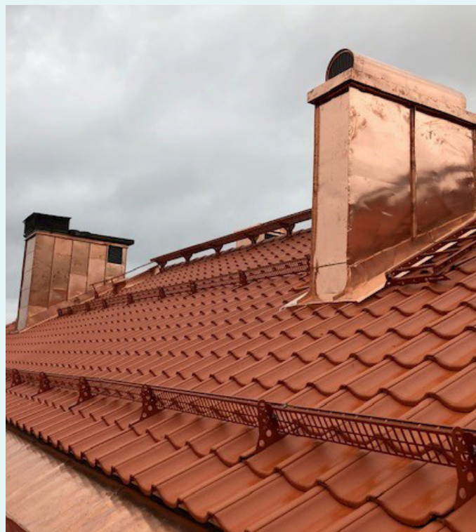
Takbyte för Stadshusparken, vilket omfattar detaljer i kopparplåt.
