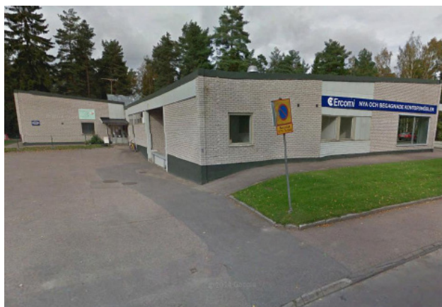
Ovan: Bilden visar befintlig byggnad på Tellus 1.
