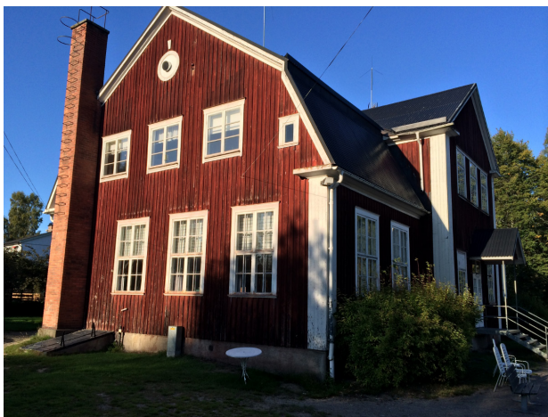
Byggnadens västra fasad, tidstypisk detaljrik skolbyggnad
