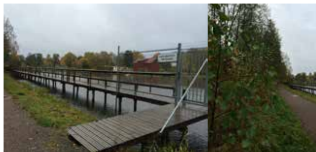
Ovan: Båtplatser vid Karlborgsbyggnaderna samt GC-väg. Vy mot nordöst.
