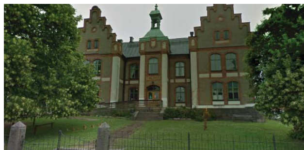
Ovan: F d Tingshuset. Fasad mot väster.
