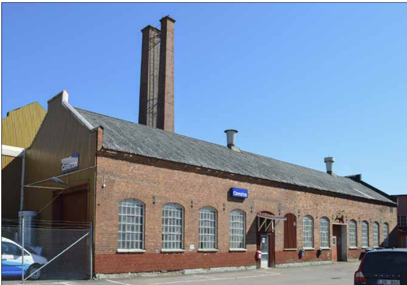
Elektra 14, Seffle motorverkstad, gamla gjuteriet.
