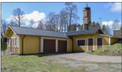
Säffle 6:51, 1870 (omkring) Kanalvillan änkesätet, gårdsbyggnad Befintligt skydd i detaljplan: Varsamhetsbestämmelse k2: Fasader skall vara träpanel, underhåll och renovering skall ske med särskild hänsyn till omgivningens kulturhistoriska värden. Hänsynsbestämmelse f1: Ny bebyggelse skall utföras med träfasader och i övrigt ta särskild hänsyn till omgivningens kulturhistoriska värden.
