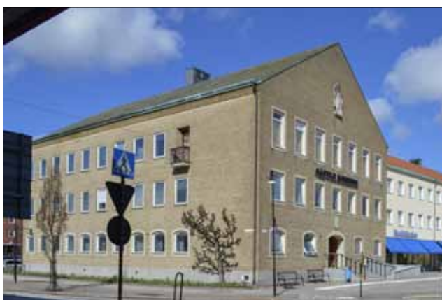
Härdén 2 (överst, mitten), Knutsbacken 7, Säffle stadshus förvaltningsbyggnaden (underst)
