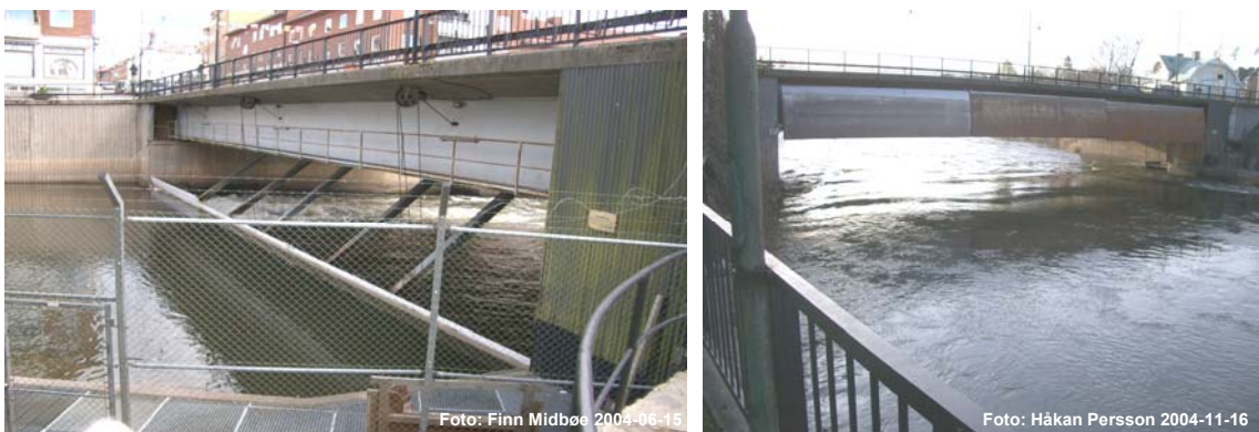
Figur 7 - 4 Dämnet som är en konstruktion under strömbron som förbinder östra Säffle centrum med kanalön. Bilden till vänster är tagen vid lågt vattenstånd då alla luckorna används för att begränsa flödet och bilden till höger är tagen vid högt vattenstånd då alla luckor är uppfällda för att lämna vattnet en så fri passage som möjligt.
