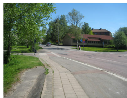
Tegnérgatan sett från väster (Enbusken 1 på höger sida)
