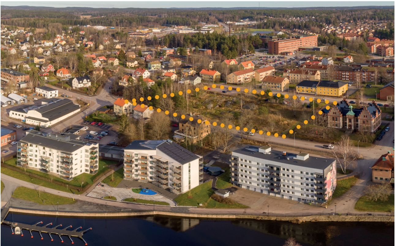
Ovan: Planområdet markerat med gul, prickad linje på snedbild över aktuell del av Säffle centrum.
