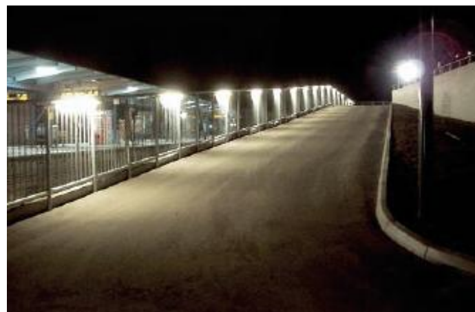
3. Räckena på gång- och cykelvägen bör bytas ut. Alternativt behålls de och belyses med en armatur. Källa: Fergin
