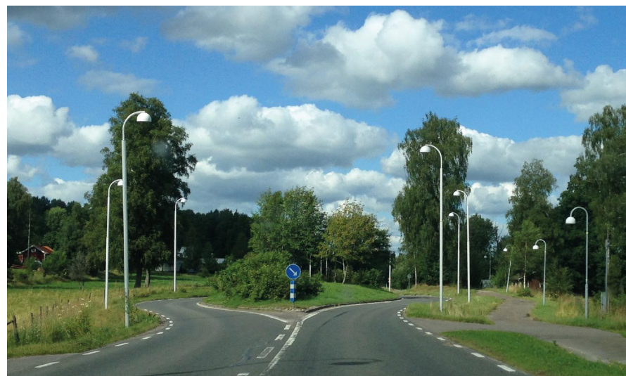
1. En typ av entré i form av en chikan som markerar att en ort börjar.
