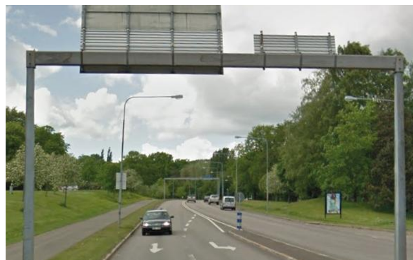
Utrustning som skyltportaler och skyltar ses över så att de hålls enkla och inte stör omgivningen. Källa: Safeline
