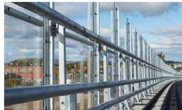
4. Om bullerskärm behöver användas är det viktigt att utsikten bibehålls över Byälven och in mot centrum. Även räckena på sträckan ska ses över och sträva efter att bibehålla utsikten. Källa: Saferoadbirsta.se
